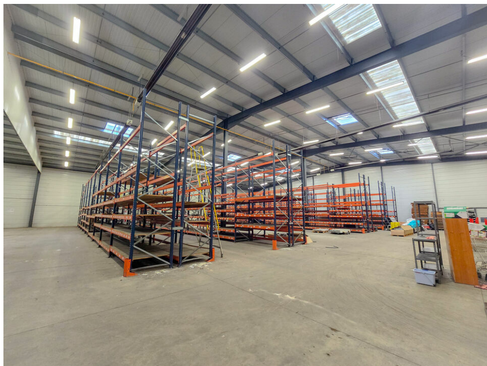
1648m 2 isolés et chauffés
